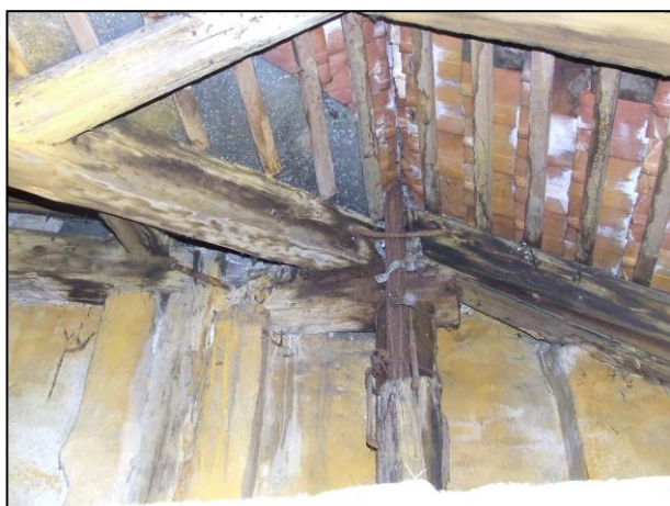
5. Antennaáttörés miatt ázó, cserélendő elemek
