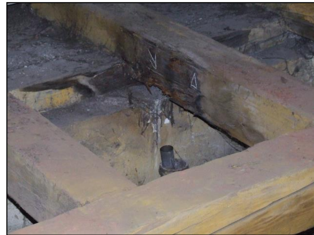
12. Hibás strang kivezetés miatti károsodás
