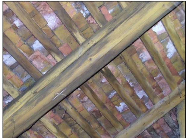
8. Kéményjárda rögzítés alatti cserélendő szarufa
