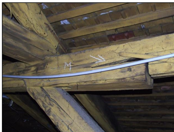
4. Széthasadt derékszelemen csatlakozás
