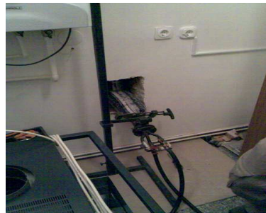
Kémény bélélcső kikeményítése, gőzölése
