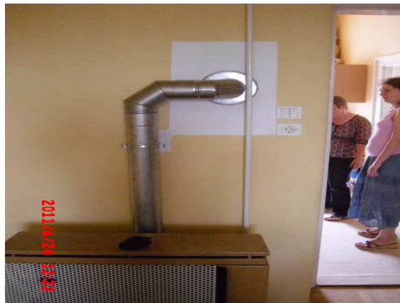
Kibélelt kémény szabvány szerinti acél füstcsővel szerelve
