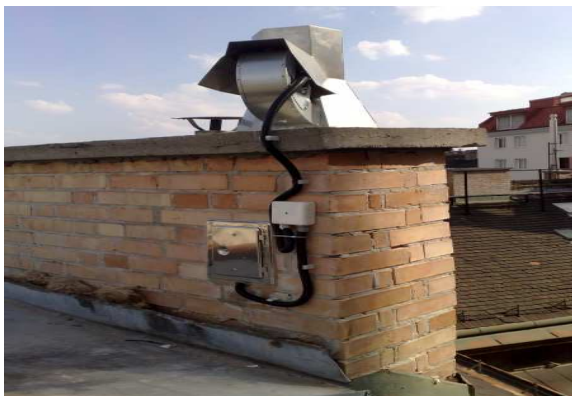
Kibélelt kémény, megszívó ventilátorral szerelve
