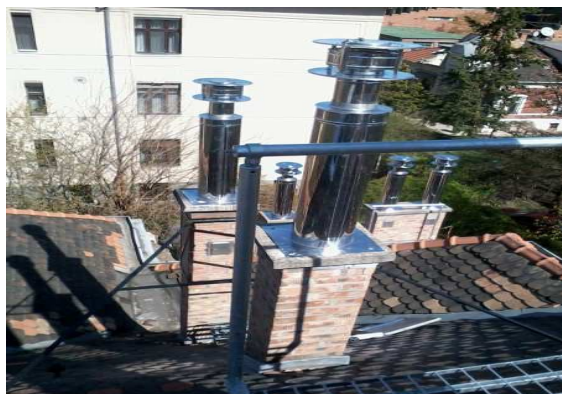
Kibélelt kémény szabvány szerinti acél füstcsővel szerelve
